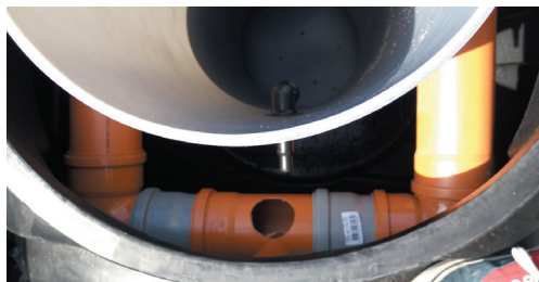
рисунок 2 Переливная система в стакане биофильтра «Rostok» Плюс
