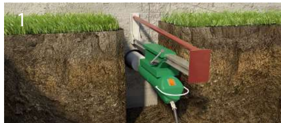
Алмазное сверление фундамента для прокладки канализационного трубопровода.
